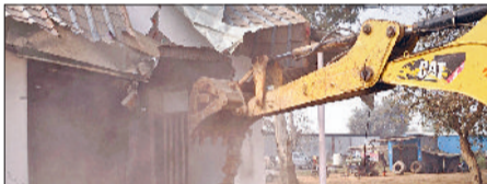
अंबाला। अवैध निर्माण को ढहाती जेसीबी।
